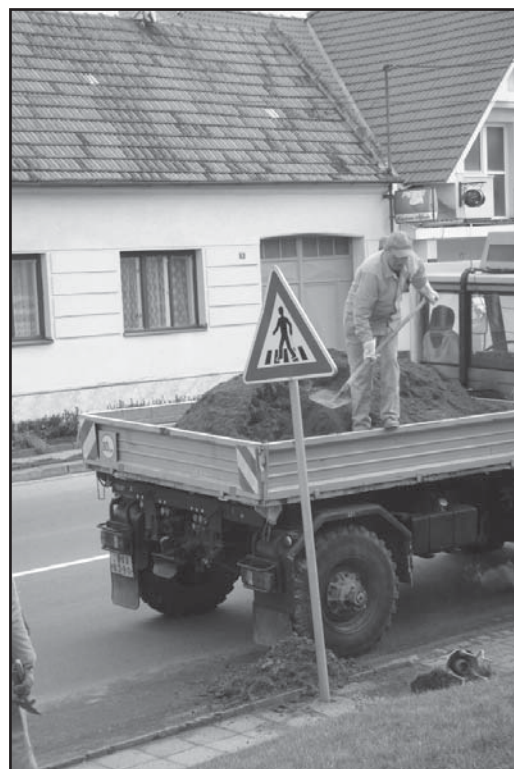
Instalace nových dopravních značek
