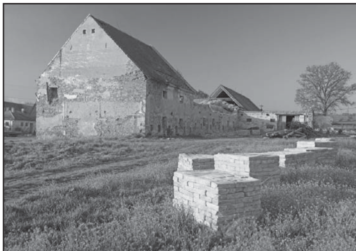
Demolice části statku
